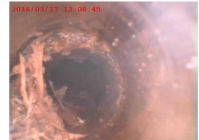
Boquilha obstruída c/ bagaço que sofreu limpeza mecânica
